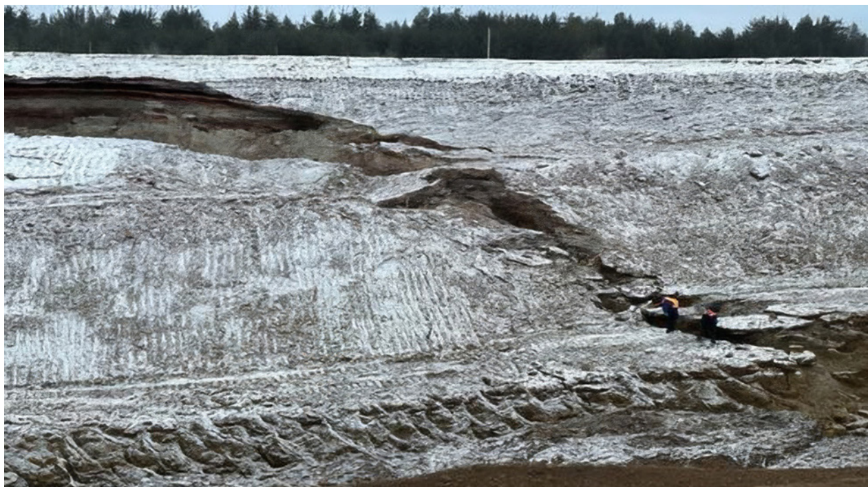
Рисунок 4. Образование трещин-заколов на 8 этапе строительства М-12
