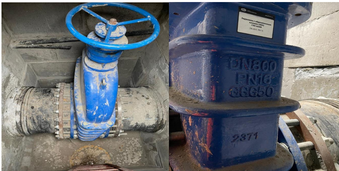
Задвижка ЗОК Ду 800 Ру 1,6 Мпа на объект проверки «Участок напорного коллектора от завода им. Карла Маркса до протоки р. Царев по Набережной Приволжского затона»
